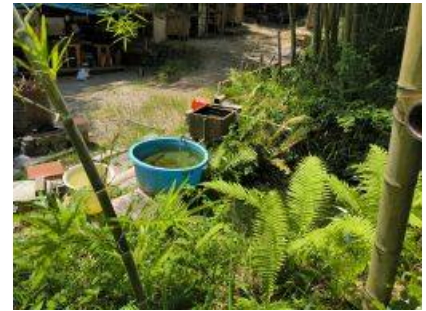
水場からのパイプ点検補修後水の流れ確認
