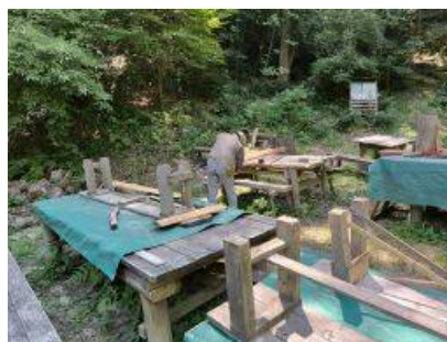
基地テーブル補修
