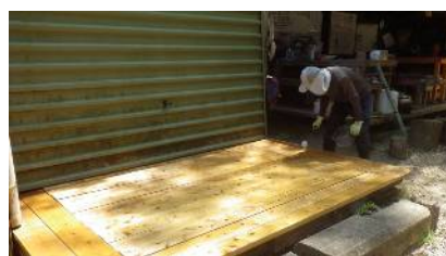
デッキ防腐剤再塗布
