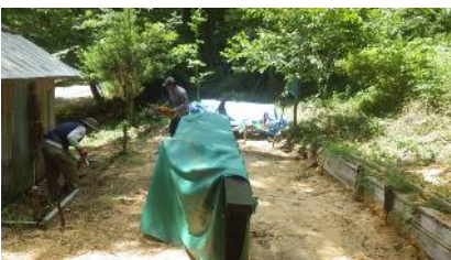
製材機周り整備
