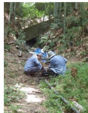
基地水源地補修
