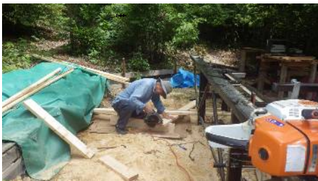
製材活用作業
