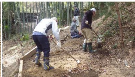
基地広場の上の山道整備
