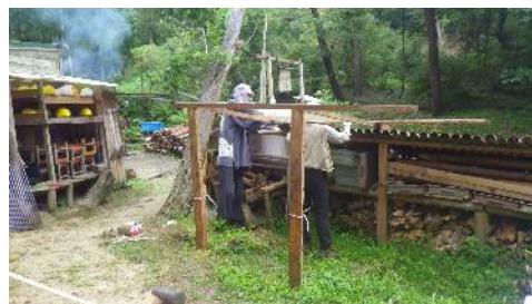
基地資材置き場拡張整備
